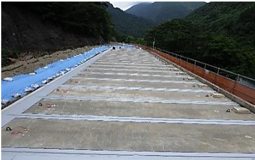
如月スノーシェッド補修工事（防水シート取替工）
