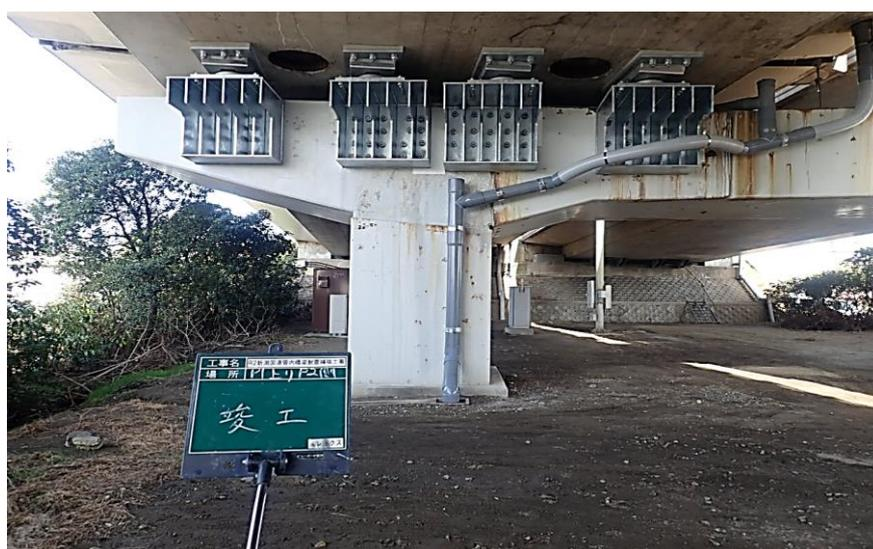
新潟国道管内橋梁耐震補強工事（水平力分担構造装置工）
