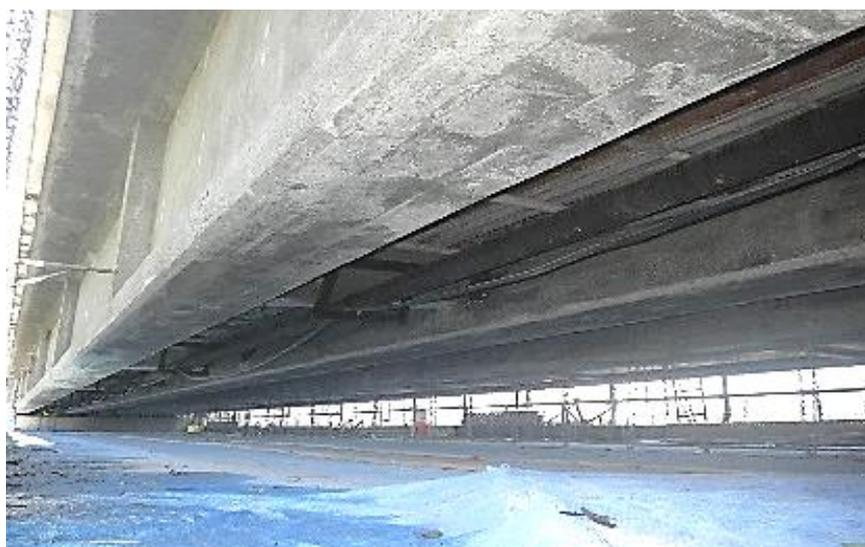
新胎内橋橋梁補修工事（断面修復工）
