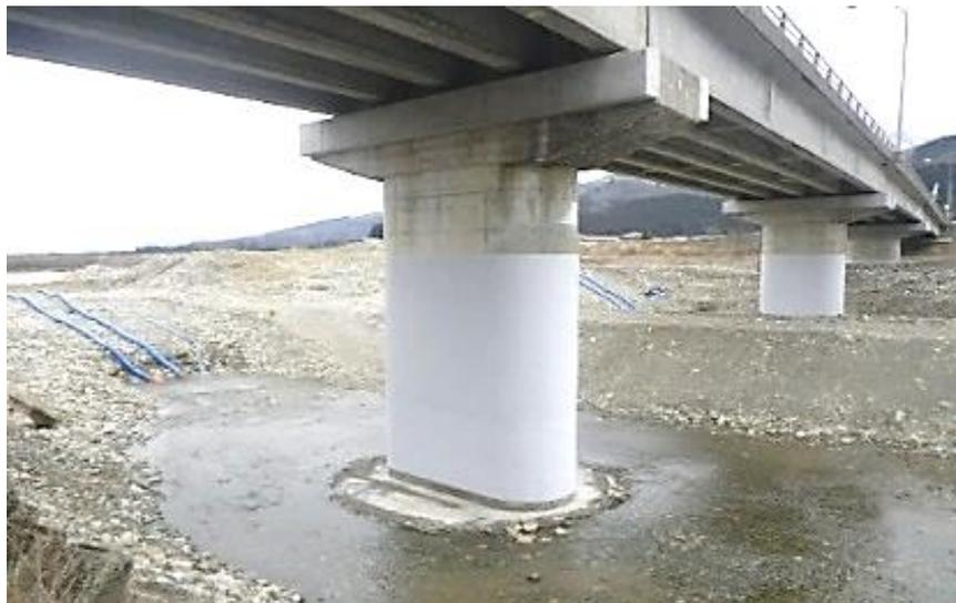
不動堂橋耐震補強 (P3)工事 (炭素繊維シート補強工)
